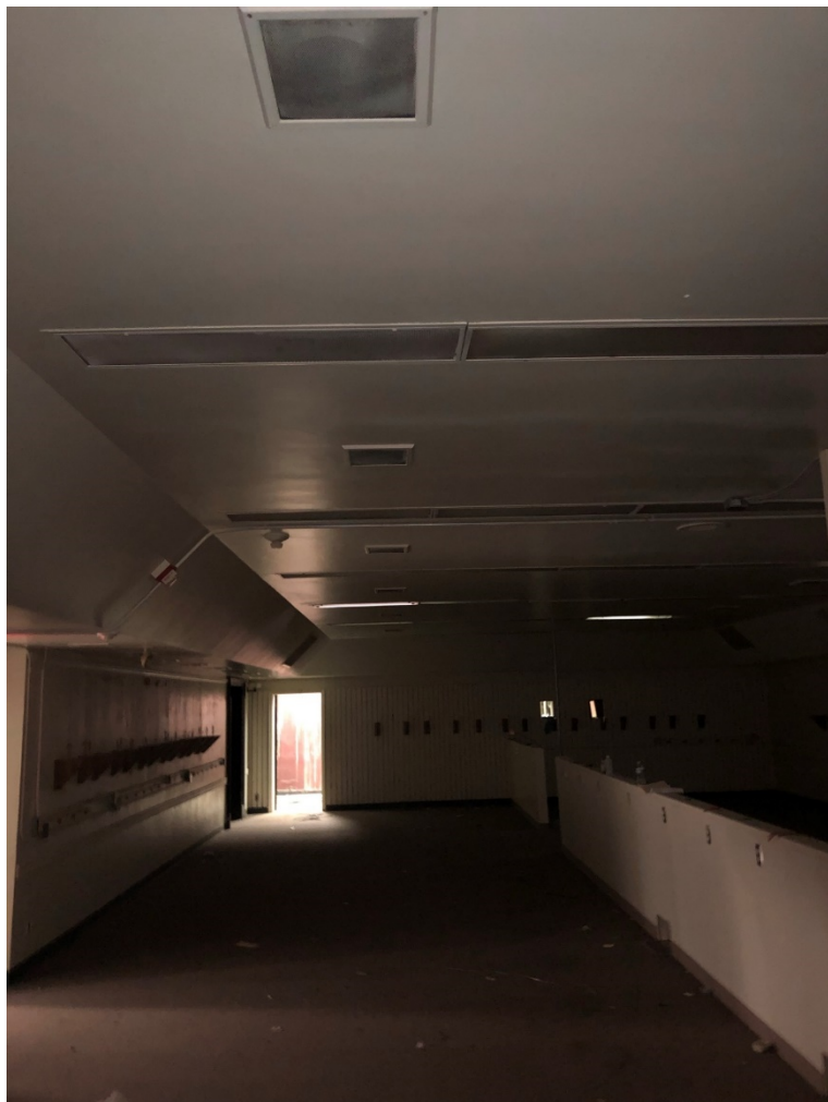
Photo OCH - B - 6: Room south of south lobby.
