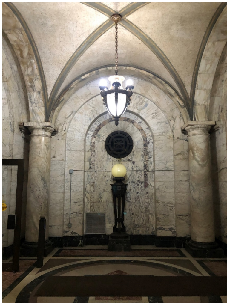
Photo OCH - 1 - 12: Vestibule
